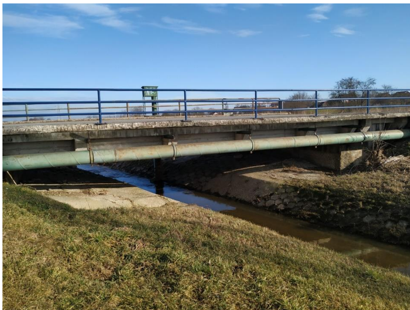
Slika 1.1/3 - Most u Obreškoj ulici (početak dionice)
